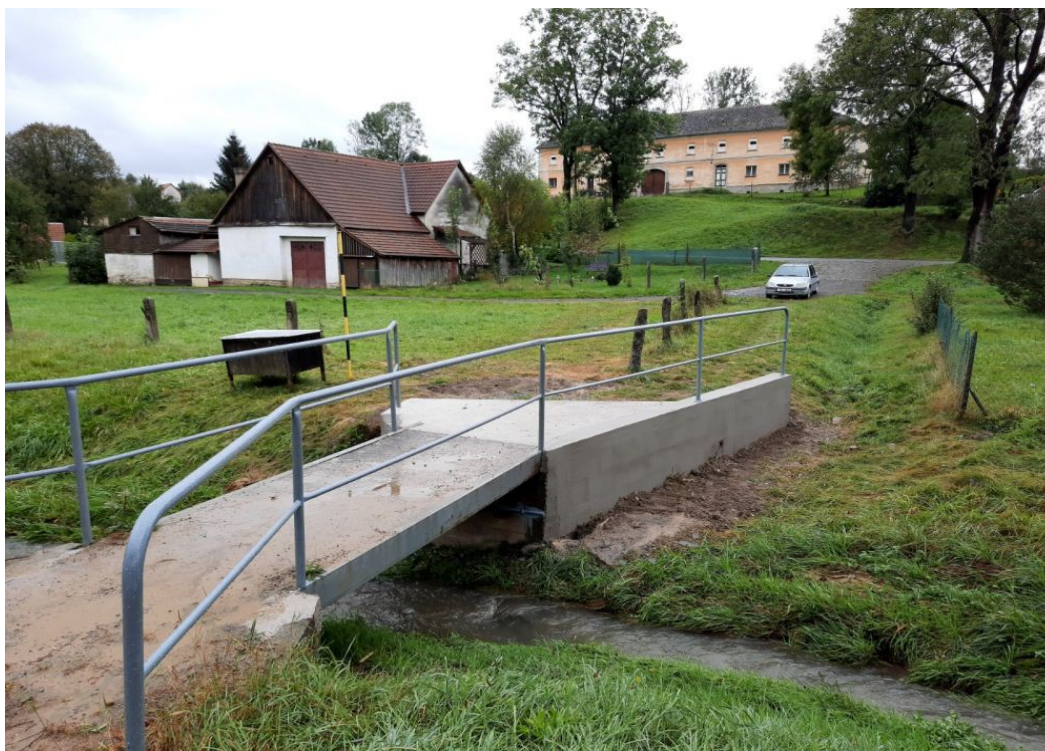
Oprava lávky v dolní části obce
