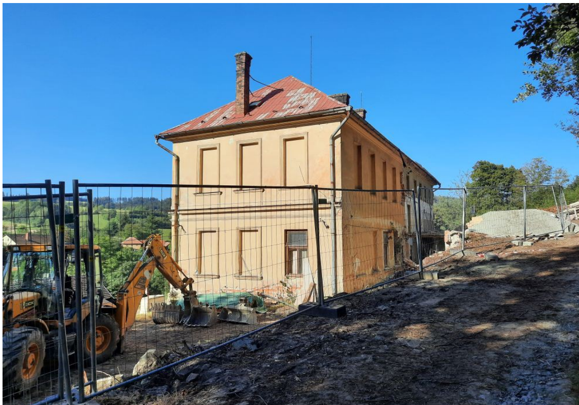
Zahájení prací na č.p. 316 - bývalá horní školka
